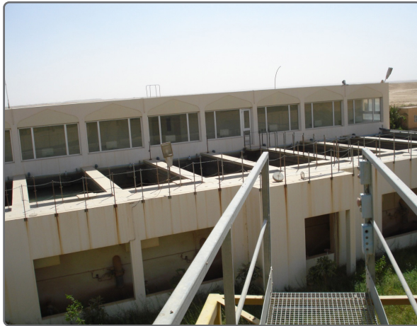
صورة (6) صورة تمثل وحدة الترشيح (الفلاتر) من الخارج
