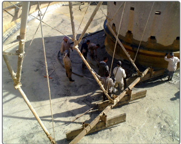
صورة (4) عملية تنظيف أحواض الترسيب
