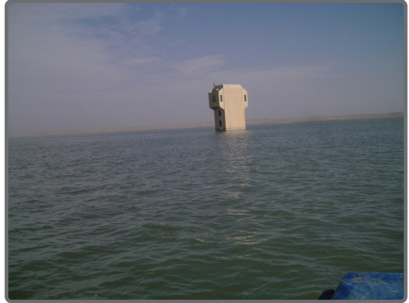
صورة (1) برج مضخات سحب الماء من البحيرة إلى مشروع ماء عنه
